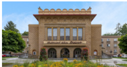
Kulturní dům Radost
