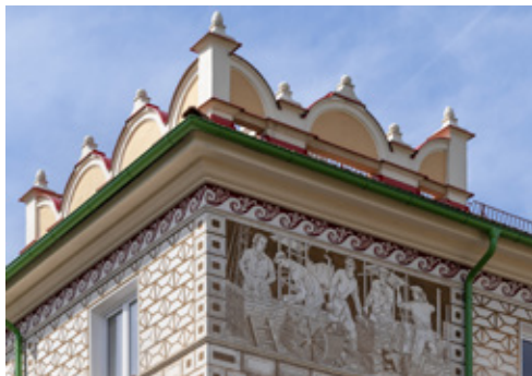
Detail architektury SORELA
