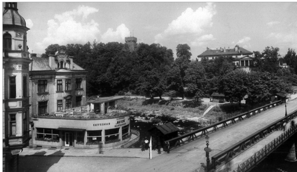
Pohled na předválečnou kavárnu Avion
