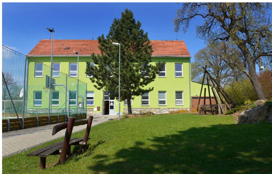
Víceúčelová budova u kostela je zázemím i pro knihovnu
